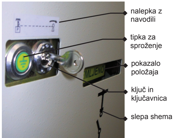
Slika 3.8: Ključavnica in tipka za sproženje ozemljilnega stikala
