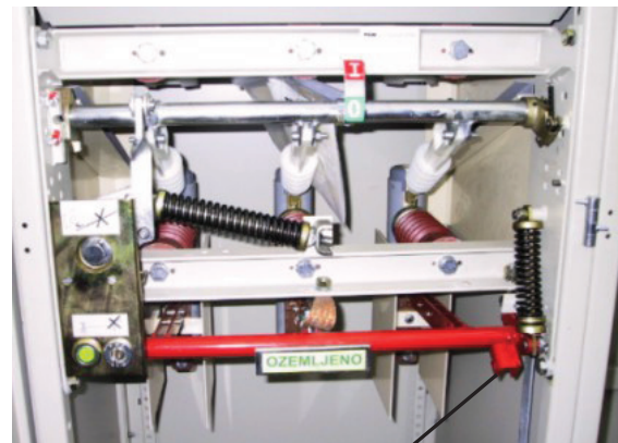
Slika 3.9: Zaklepanje odprtine za odpiranje ozemljilnega stikala
