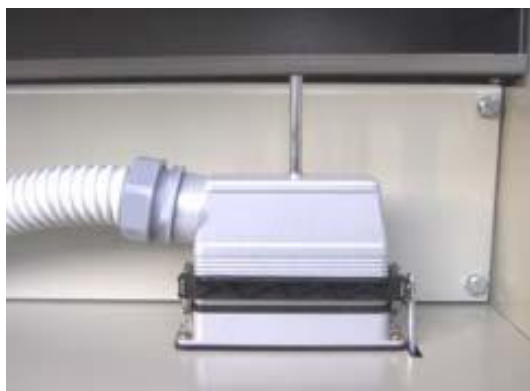
Slika 4.5: Vtikač i vtičnica konektorja s ključem konektorske blokade
