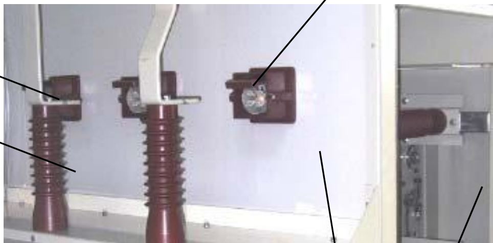
Slika 6.6: Pregrada med zbiralkami in vozičkom
