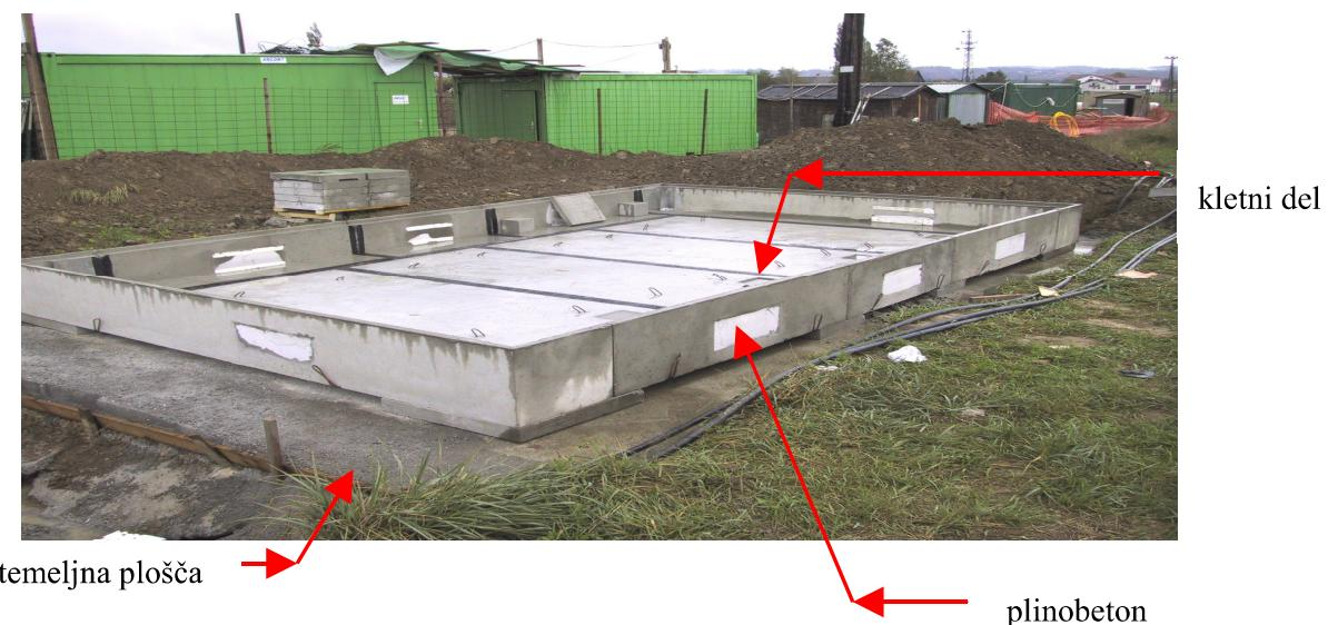
Slika 9: Betonski podkletitveni elementi
