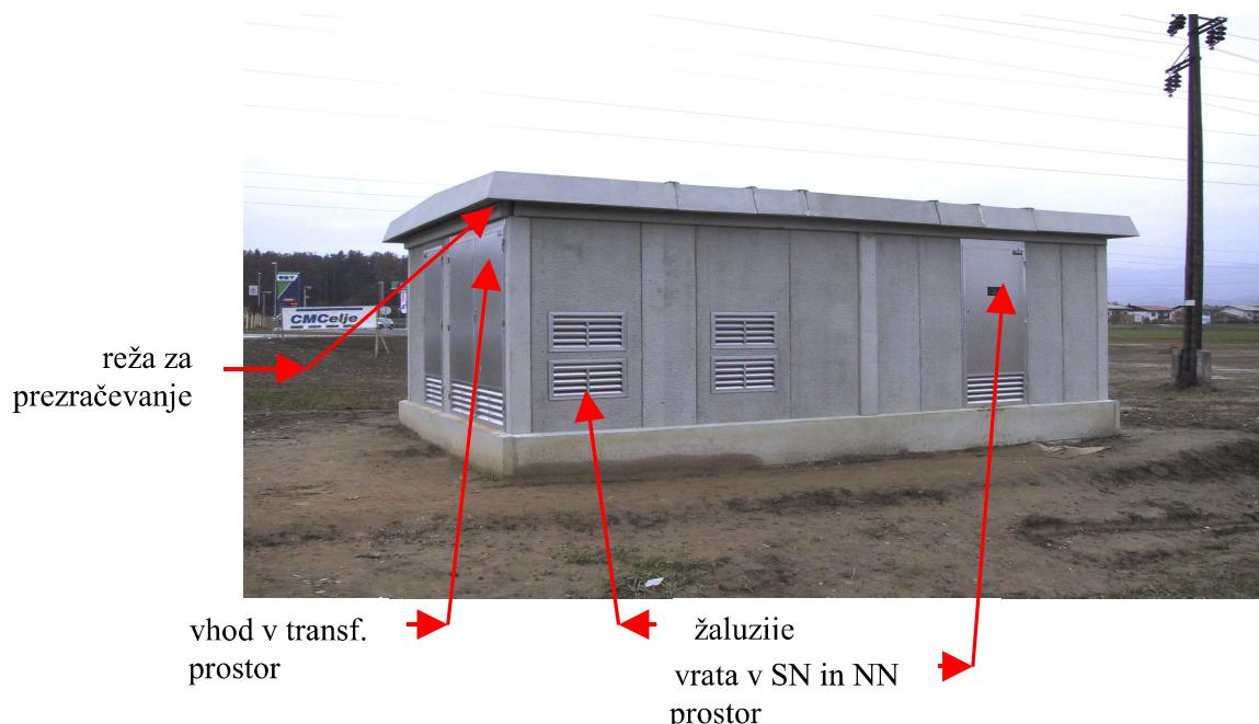
Slika 15: Ključavniciarski elementi betonske transformatorske postaje
