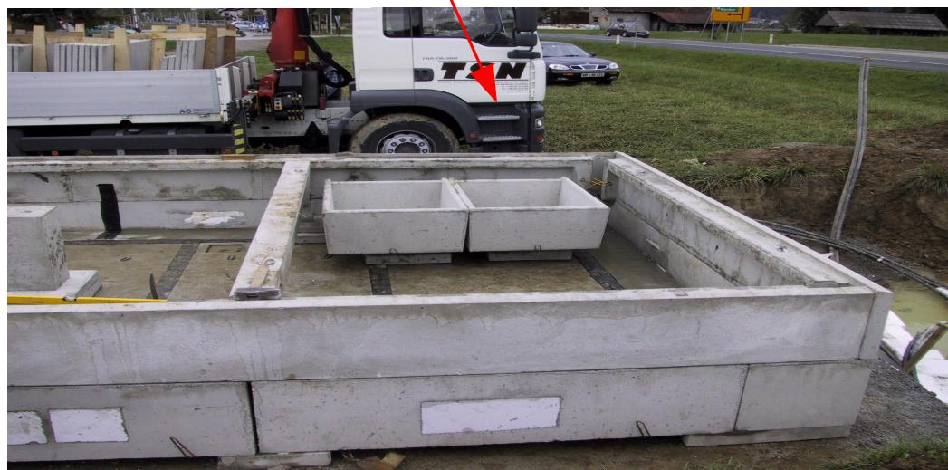
Slika 10.: Betonska klet (transformatorski del)
