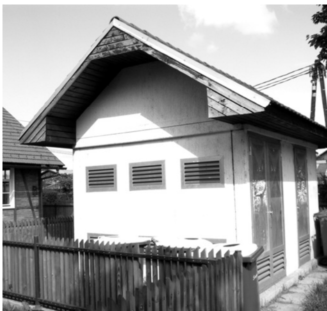
Slika 13: Betonska transformatorska postaja z dvokapnico
